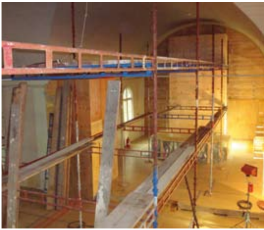
Koret under renoveringen 2007-08. Foto: Bo Hagberg.
